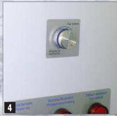
4 Fan speed controller
